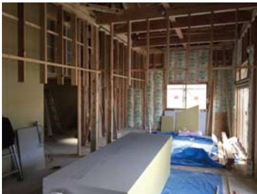
内造りをしている様子
