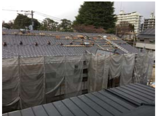
瓦を葺いている屋根の様子
